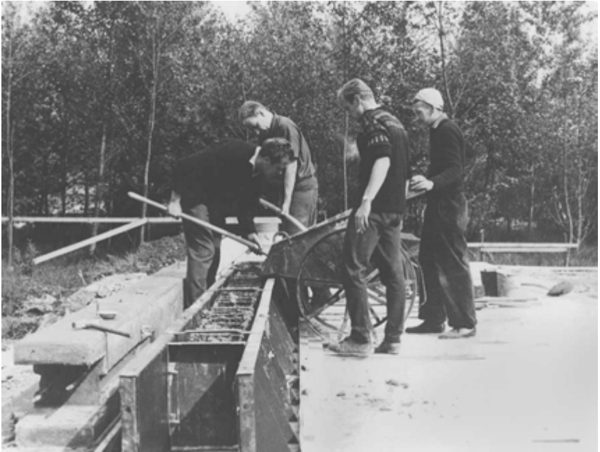
1963 - Bei der Fa. Haas in Kuhbach werden die Betonfertigteile für die Halle betoniert.
