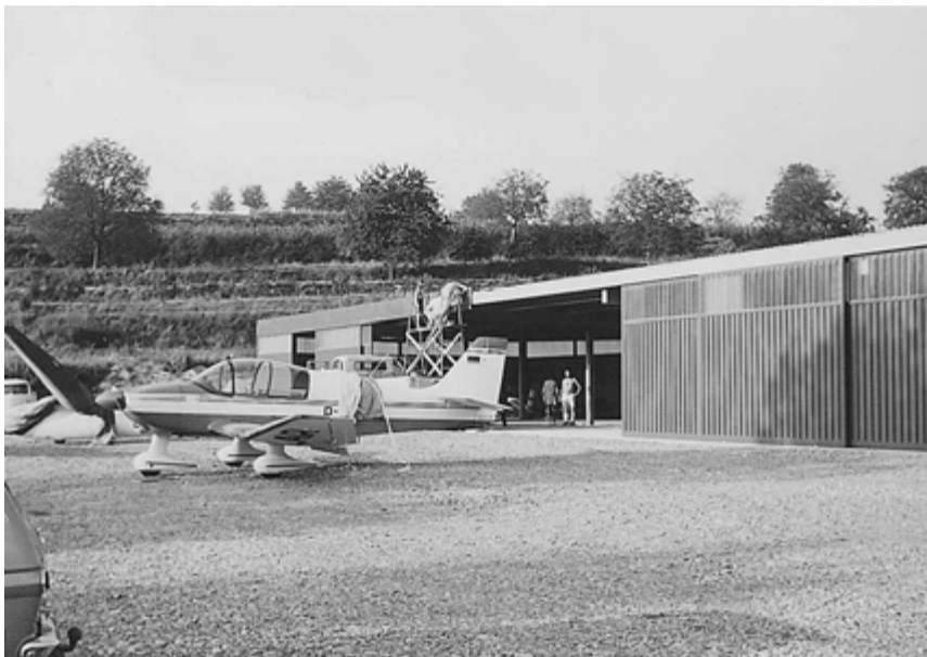
Mai 1973: Die Remorqueur D-ELAR vor der nahezu fertigen Flugzeughalle.
